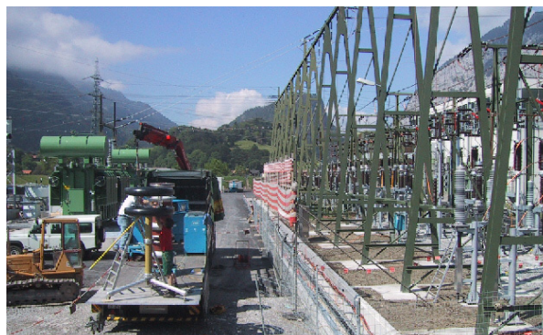
Installation d'essai sur un camion
