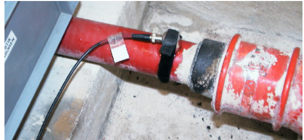
Capteur acoustique de DP sur une jonction 150 kV
